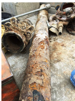
Ci-contre: ancien réseau déposé
